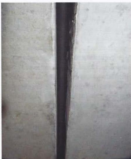
Abbildung 11: Der eingebaute CoJackHydra-Schlauch | Foto: S & P Consult GmbH
