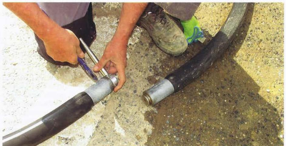
Abbildung 6: Zusammenfügen der beiden Schlauchenden auf der Baustelle | Foto: S & P Consult GmbH
