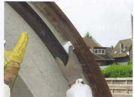
Abbildung 9: Styropor-Klötzchen zur Lagesicherung des Schlauchs | Foto: S & P Consult GmbH
