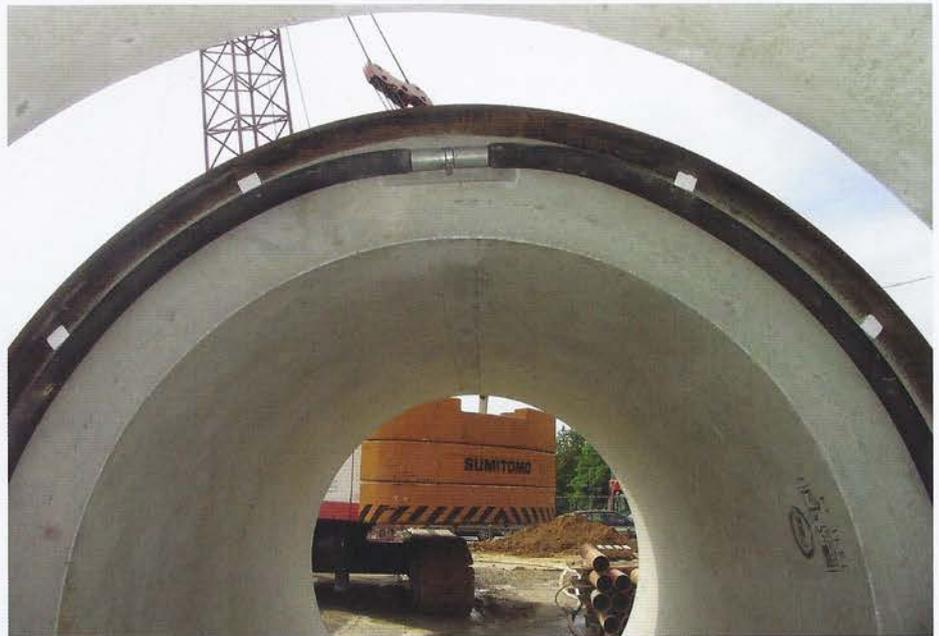
Abbildung 10: Auf dem Rohrspiegel fertig positionierter Schlauch | Foto: S & P Consult GmbH
