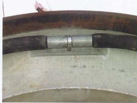
Abbildung 8: Positionierung der Schlauchverbindung auf dem Rohrspiegel | Foto: S & P Consult GmbH
